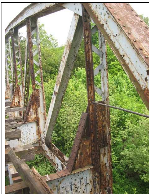
Fot.1 Korozja słupka kratownicy
