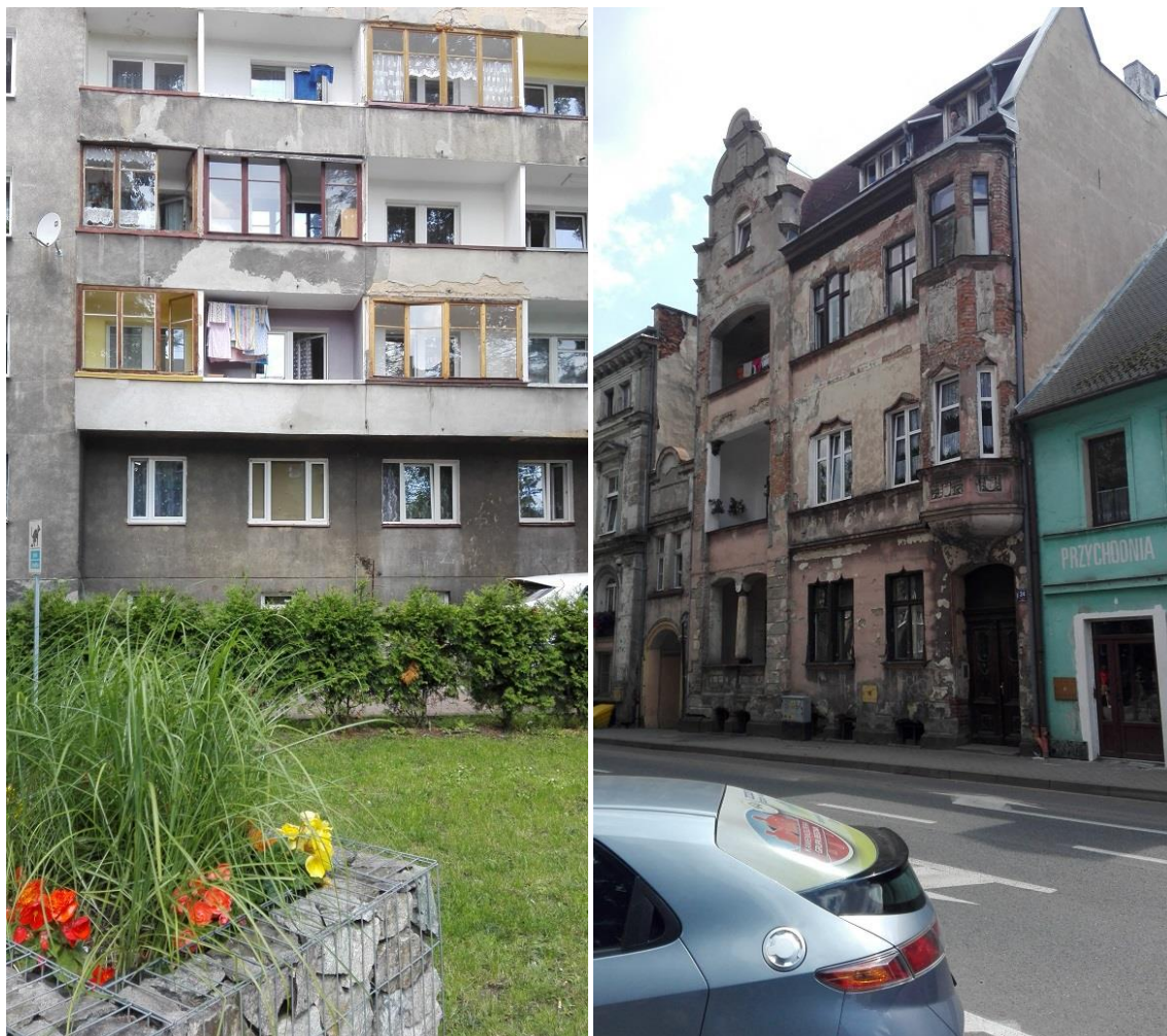
Fot. 8. Obiekty mieszkalne w okolicy skweru księcia Bolka II (ulica Ogrodowa, ul. Wojska Polskiego)
