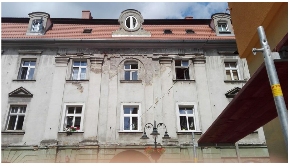
Fot. 3. Obiekt mieszkalny przy ulicy Karola Miarki
