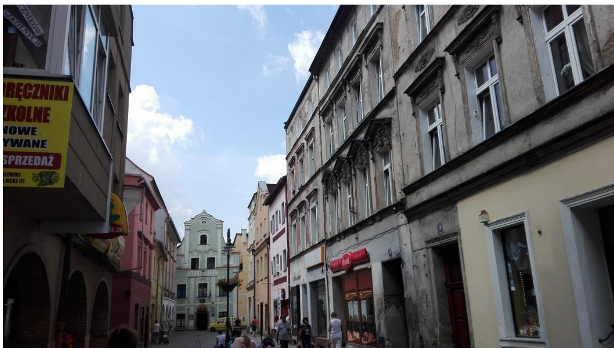
Fot. 2. Kamienice przy ulicy Mickiewicza w Kamiennej Górze
