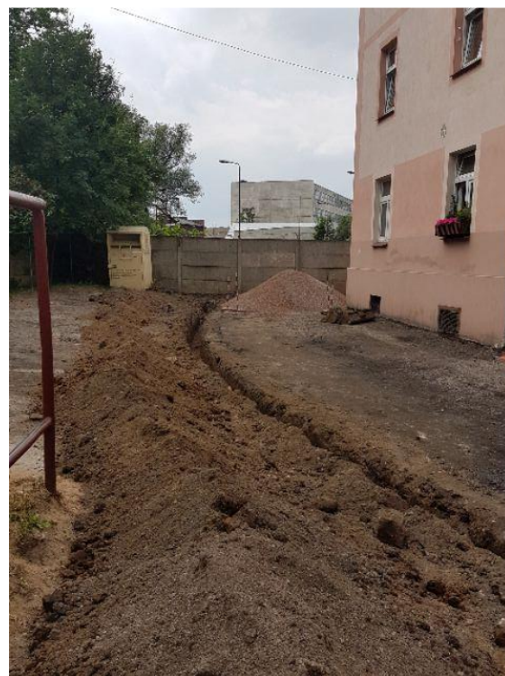
budowę sieci wodociągowej w ulicy Sportowej
