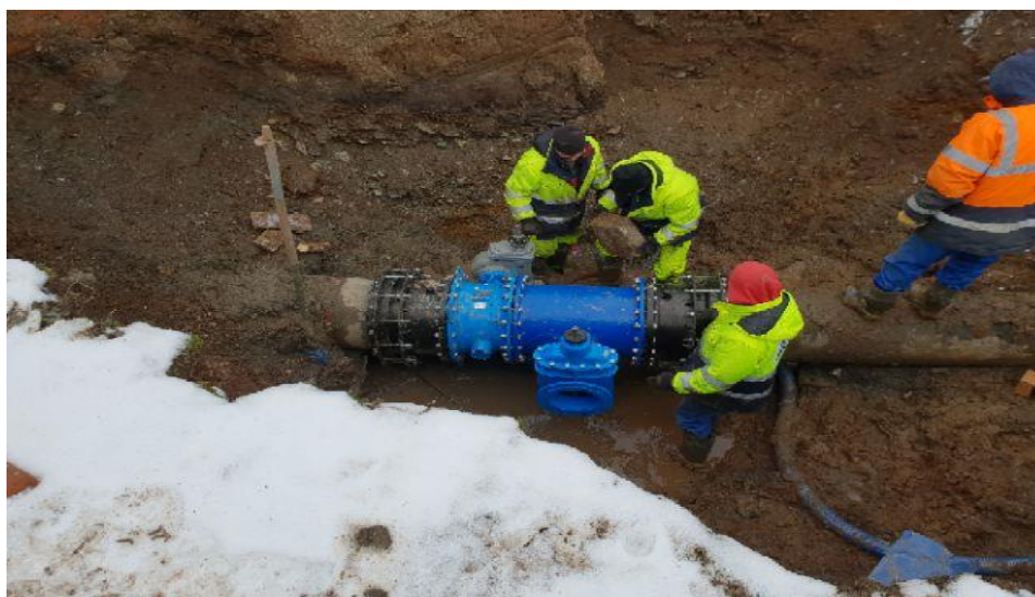
budowę sieci wodociągowej w ulicy Zielonej
