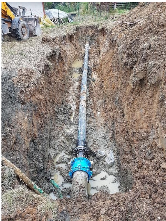
budowę sieci w ulicy Lubawskiej
