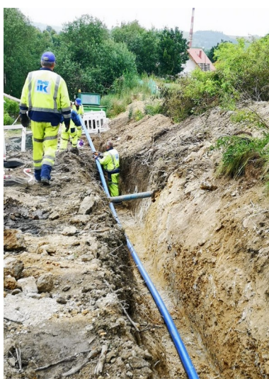
Budowa sieci wodociągowej i kanalizacyjnej – ul. Napoleońska
