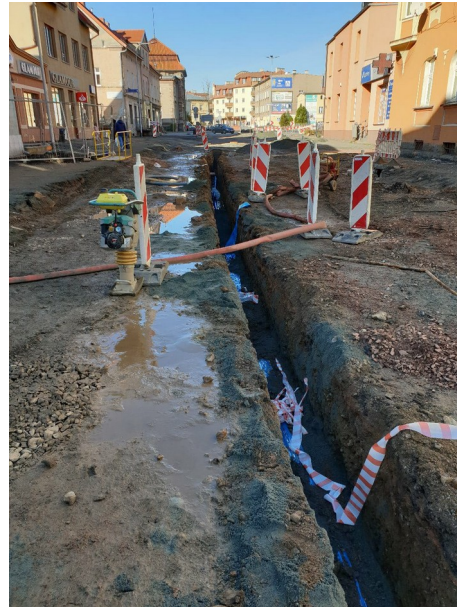
Modernizacja sieci wodociągowej – ul. Papieża Jana Pawła II - I etap
