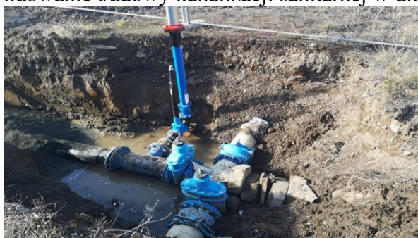
Budowa węzła wodociągowego ul. Zielona
