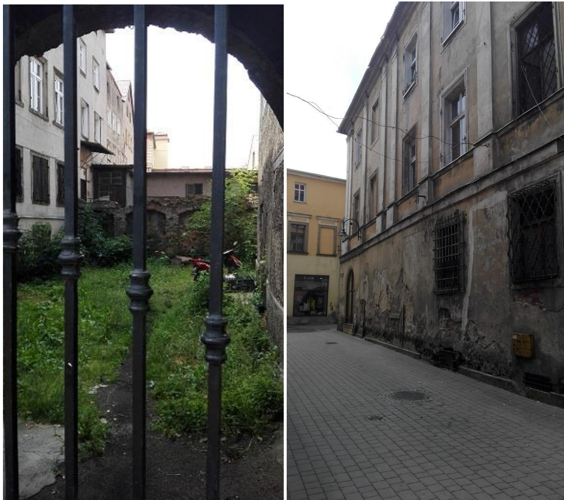
Fot. 7. Zdewastowana przestrzeń pomiędzy budynkami oraz zdewastowany obiekt przy ulicy Młyńskiej
