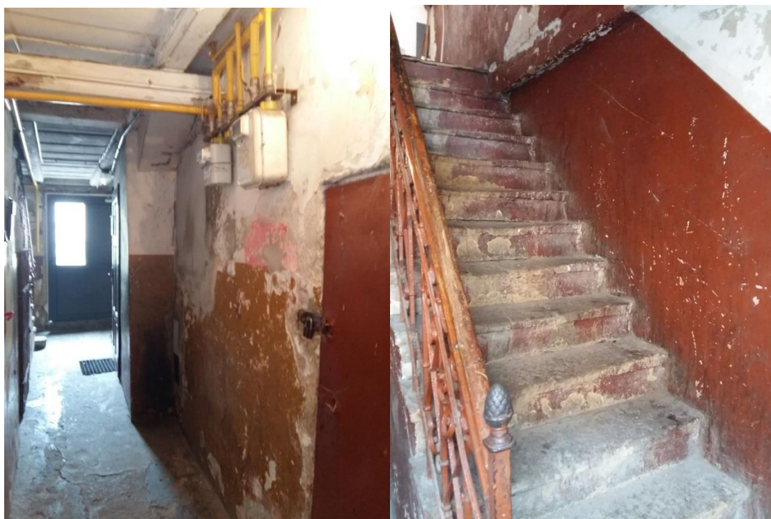
Fot. 9. Wygląd części wspólnych obiektów mieszkalnych przy ul. Kościuszki
