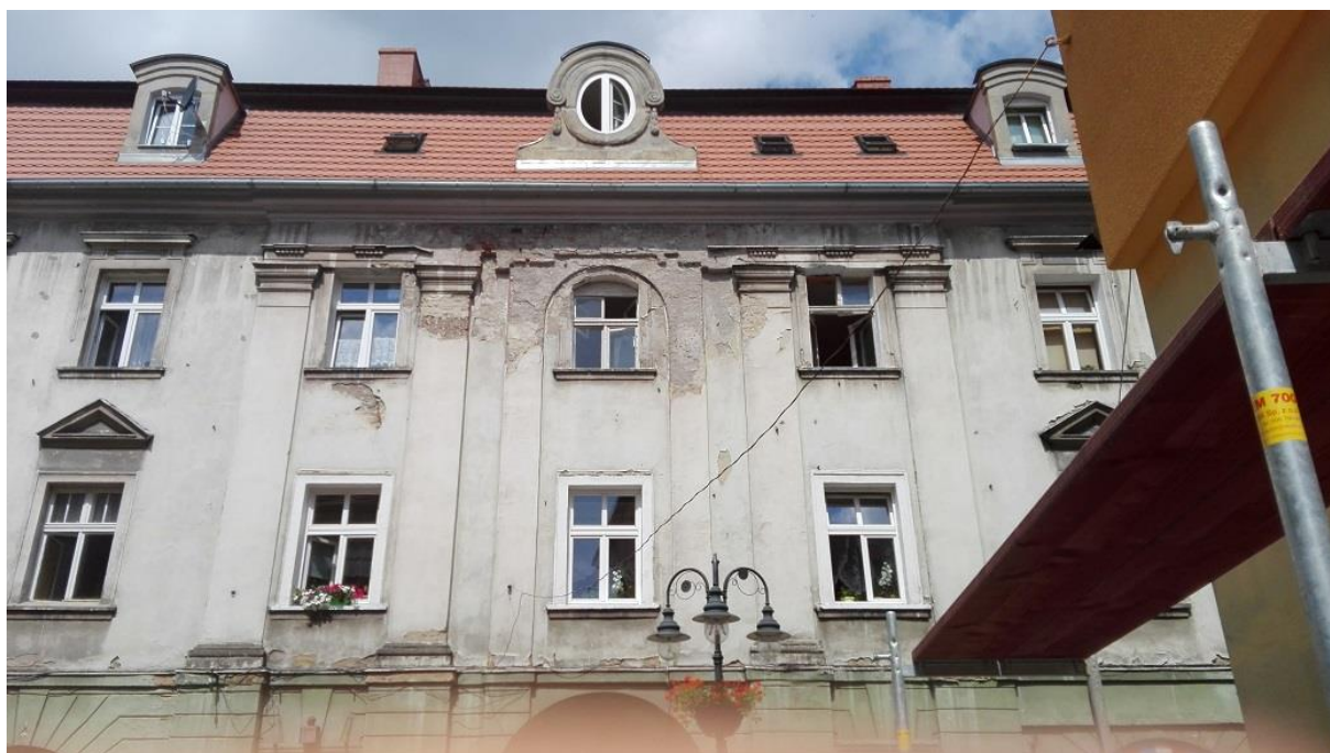
Fot. 3. Obiekt mieszkalny przy ulicy Karola Miarki
