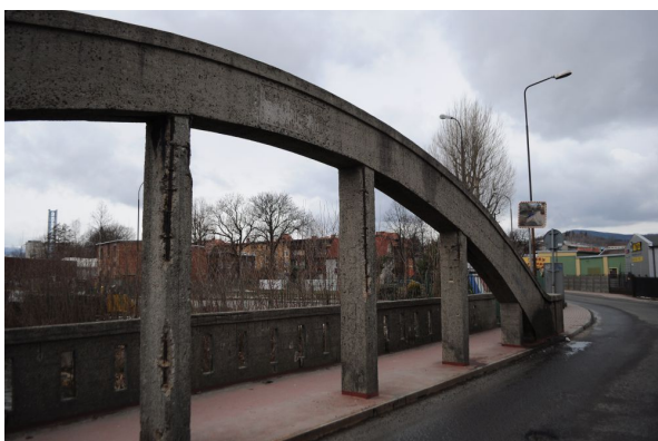
Rys. 2.3. Skala uszkodzeń wieszaków
