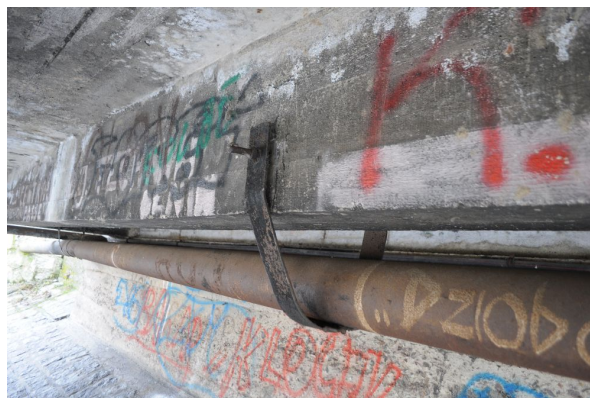
Rys. 6.4. Zawiesie rury osłonowej pod mostem
