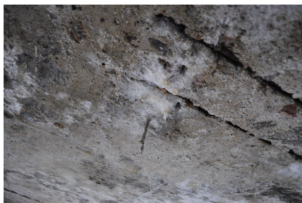
Rys. 3.4. Przecieki z izolacji, wykwyty wapienne
