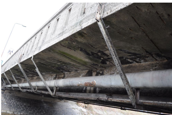
Rys. 3.1. Belki podłużne i spód wspornika
