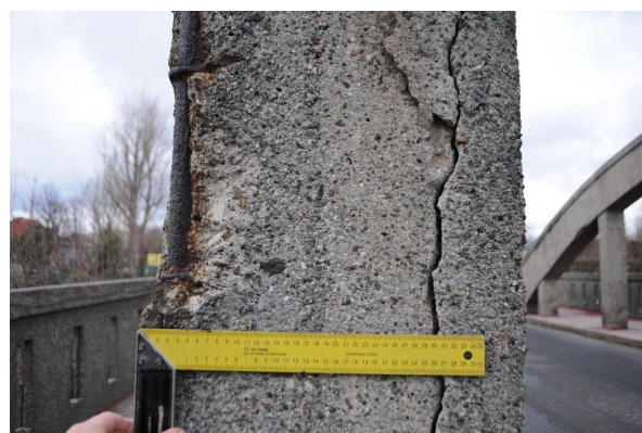
Rys. 2.6. Uszkodzenie wieszaka
