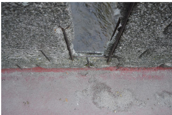
Rys. 5.3. Głębokie ubytki betonu balustrad
