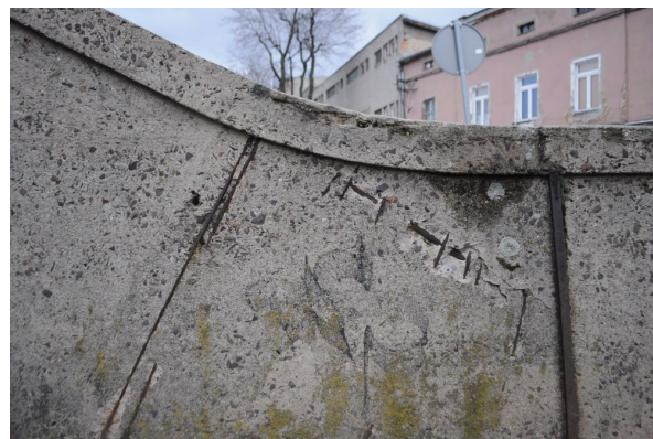
Rys. 2.2. Uszkodzenia powierzchniowe dźwigara
