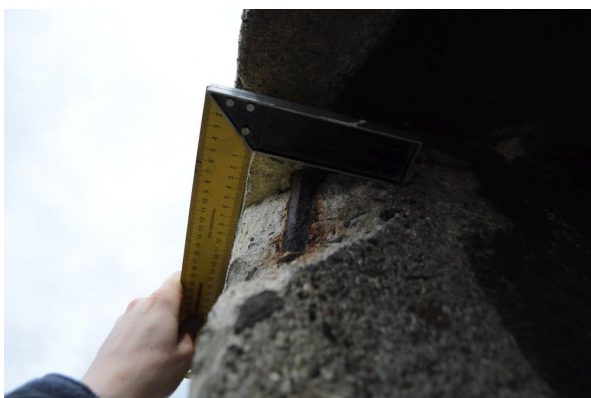
Rys. 2.7. Uszkodzenie wieszaka
