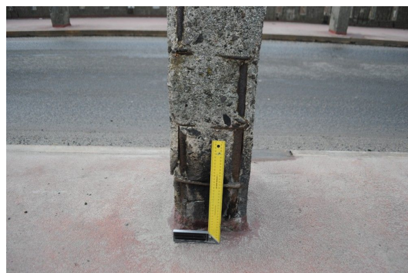
Rys. 2.4. Uszkodzenia wieszaka
