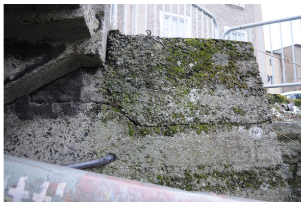
Rys. 4.4. Pęknięcie ściany oporowej
