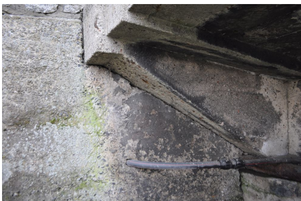
Rys. 4.3. Ściana oporowa i skrajna poprzecznica
