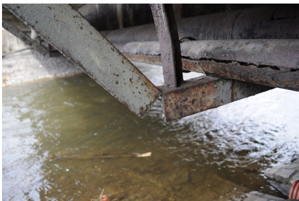
Rys. 6.3. Korozja elementów stalowych
