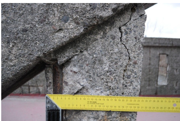
Rys. 2.5. Uszkodzenie wieszaka
