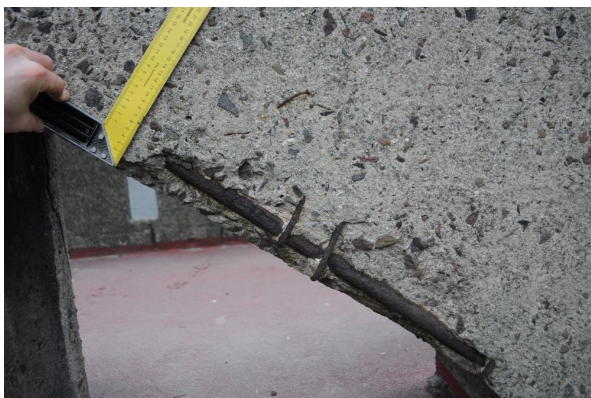
Rys. 2.1. Uszkodzenie krawędzi dźwigara
