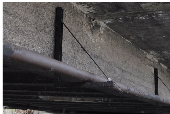
Rys. 6.2. Rury osłonowe i konstrukcja wsporcza
