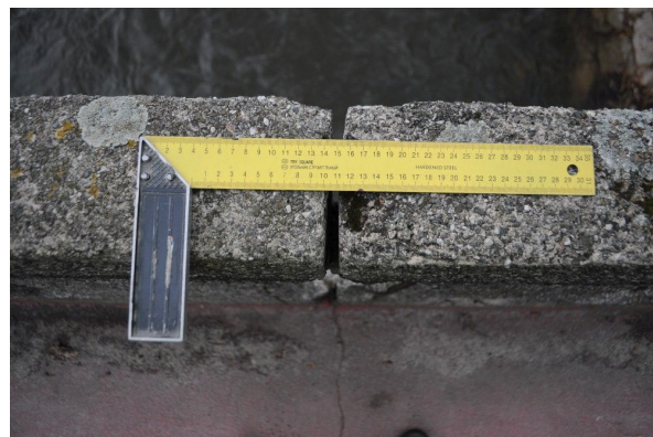
Rys. 5.4. Pochwyt (w tle pęknięty wspornik)
