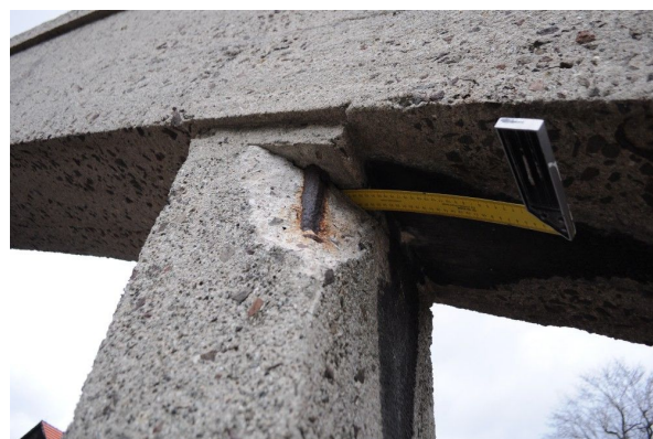
Rys. 2.8. Połączenie wieszaka i łuku
