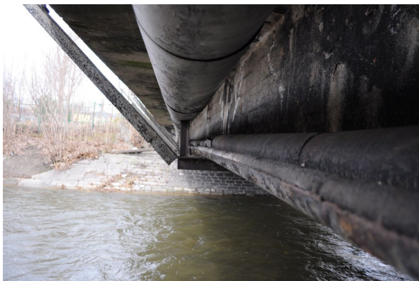
Rys. 6.1. Rury osłonowe i konstrukcja wsporcza
