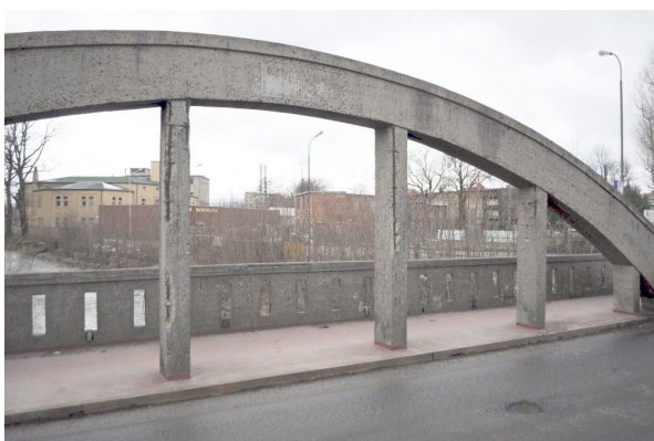
Rys. 11. Widok dźwigara łukowego
