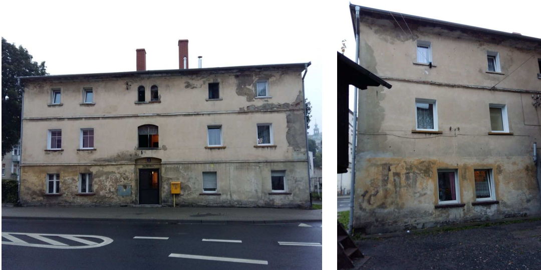
Fot. Widok elewacji budynku z widocznymi ubytkami tynku i zawilgoceniami
