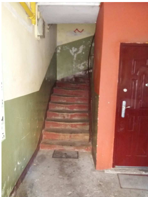
Fot. Widok zawilgoconych i zniszczonych tynków ścian wewnętrznych klatki schodowej
