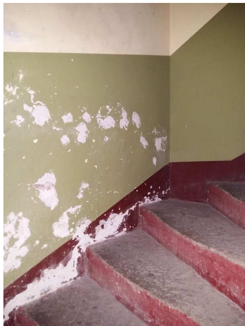
Fot. Widok zawilgoconych i zniszczonych tynków ścian wewnętrznych klatki schodowej
