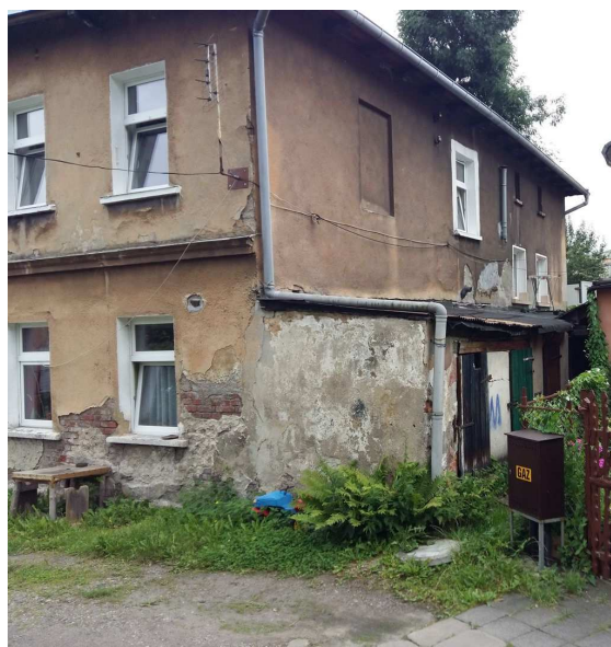
Fot. Widok elewacji budynku z widocznymi ubytkami tynku i zawilgoczeniami
