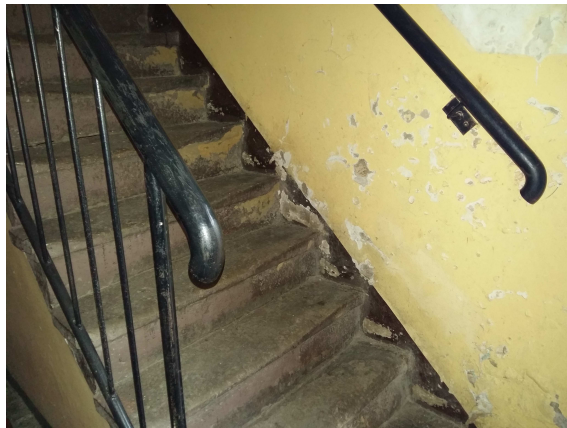
Fot. Widok zawilgoconych i zniszczonych tynków ścian wewnętrznych klatki schodowej
