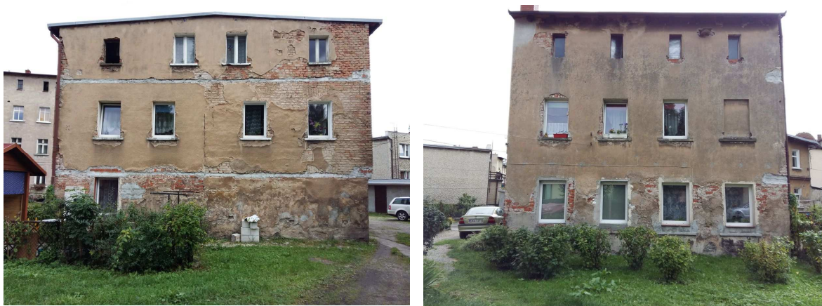
Fot. Widok elewacji budynku z widocznymi ubytkami tynku i zawilgoceniami
