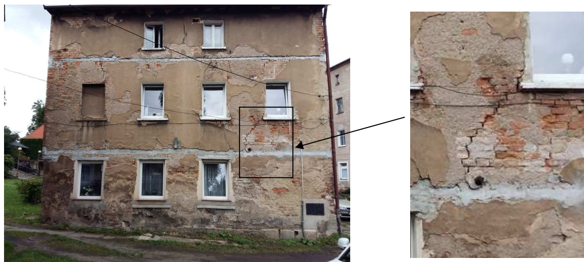
Fot. Widok elewacji budynku z widocznymi pęknięciami muru
