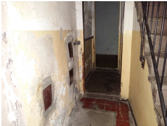
Fot. Widok zawilgoconych i zniszczonych tynków ścian wewnętrznych klatki schodowej
