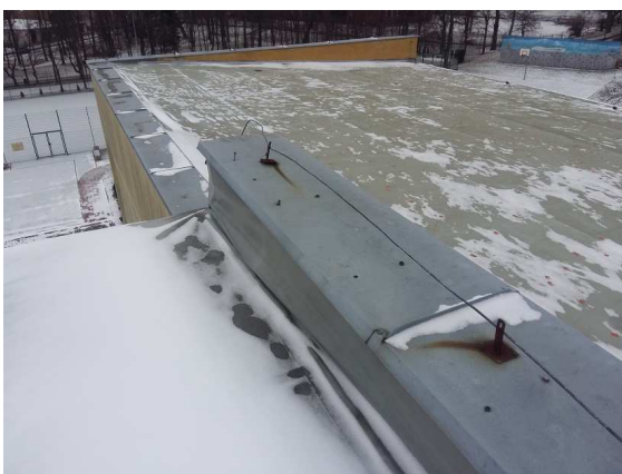
Fot. Widok nakryw murków obróbek kominów i uszczelnień styków połączeń z pionowymi murkami
