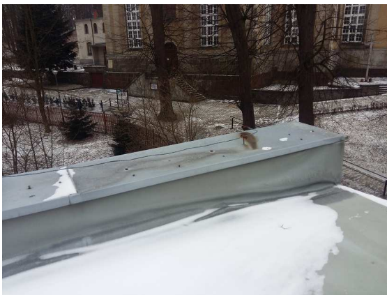
Fot. Widok uszkodzeń membrany dachowej
