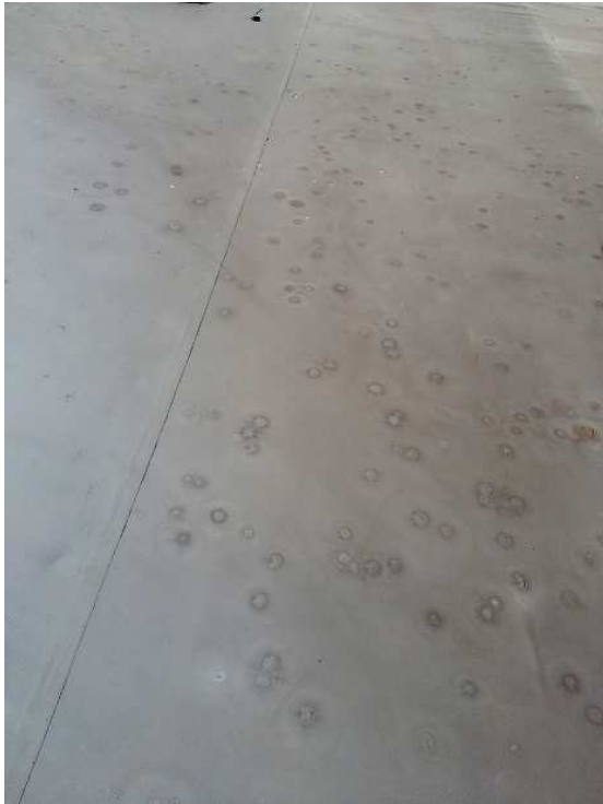
Fot. Widok uszkodzeń membrany dachowej
