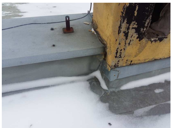
Fot. Widok nakryw murków obróbek kominów i uszczelnień styków połączeń z pionowymi murkami
