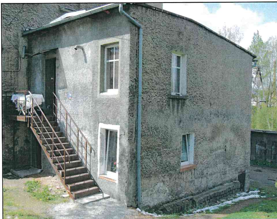
Budynek przy ul. Legnickiej 1a w Kamiennej Górze – po remoncie
