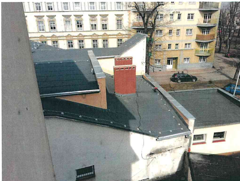
Dach budynku sali sportowej przy ul. Kościuszki
