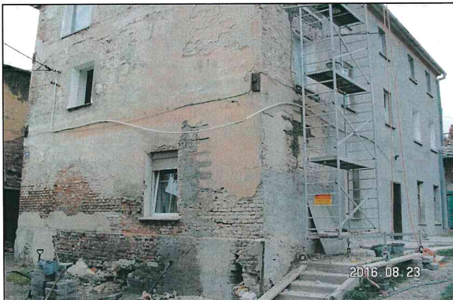
Budynek przy ul. Wałbrzyskiej 11 w Kamiennej Górze – przed remontem
