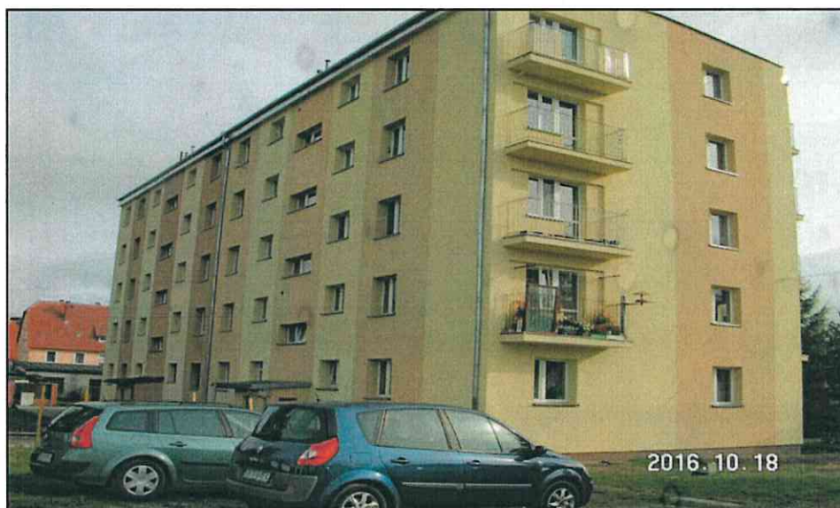
Budynek Wspólnoty Mieszkaniowej ul. Jeleniogórska 36 i 38 w Kamiennej Górze – po remoncie
