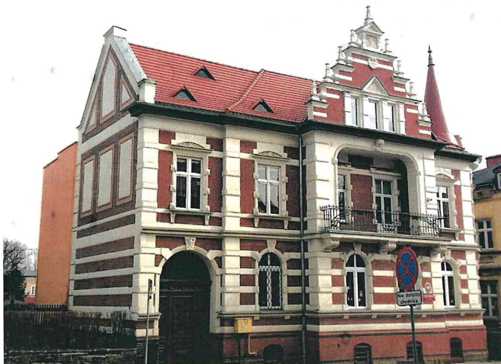
Remont dachu budynku Przedszkola Publicznego nr 3
