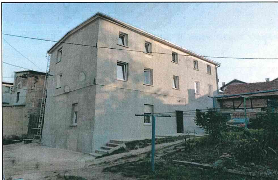
Budynek Wspólnoty Mieszkaniowej ul. Wałbrzyskiej 11 w Kamiennej Górze – po remoncie
