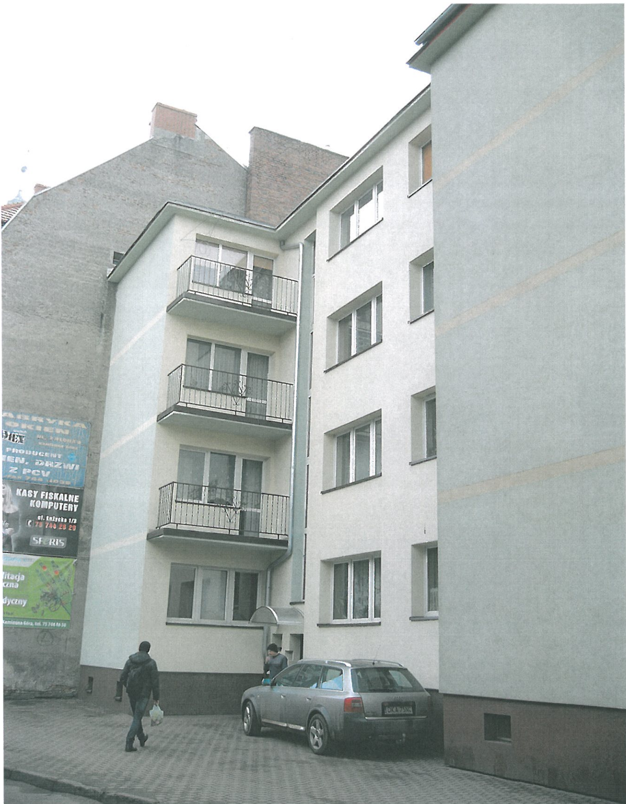
Budynek wspólnoty ul. Waryńskiego 3 w Kamiennej Górze (w zarządzie DOMINO – po remoncie – udział 13 tys. zł (10,8%)
