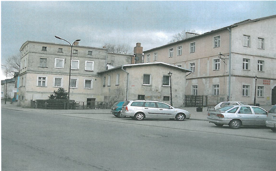
Budynek Wspólnoty Mieszkaniowej przy ul. Kościuszki 46 (przed remontem)
