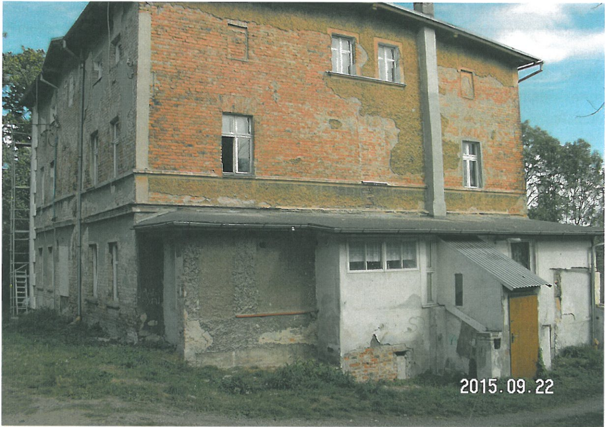
Budynek komunalny ul. Polna 6 w Kamiennej Górze (przed remontem)
