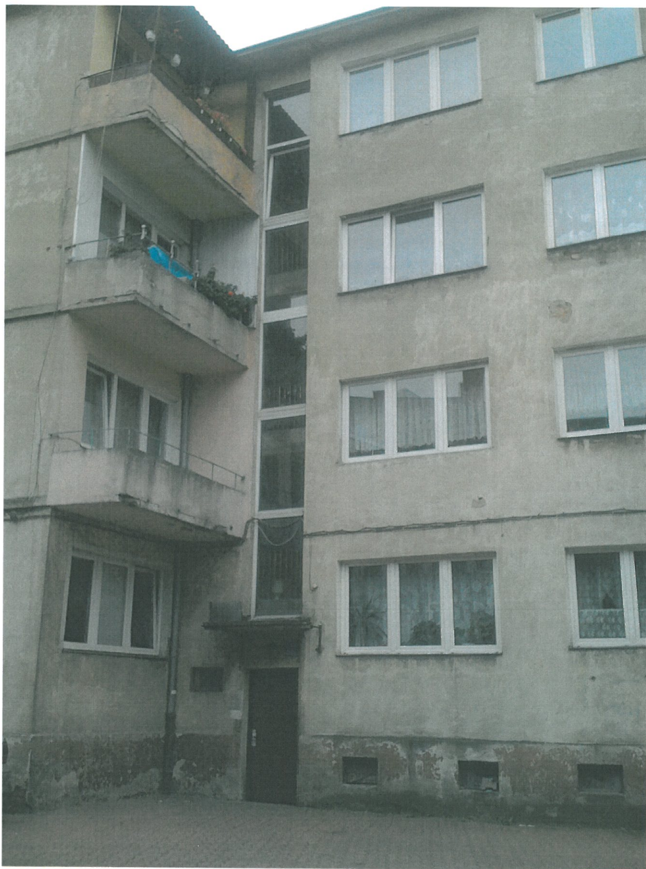
Budynek wspólnoty ul. Waryńskiego 3 w Kamiennej Górze (w zarządzie DOMINO – przed remontem)
